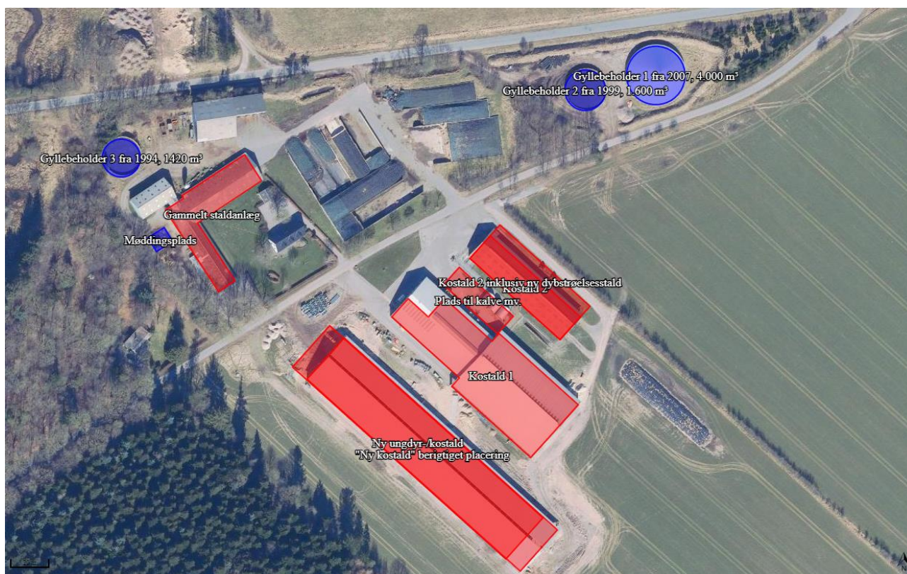
Figur 2: Husdyrbrugets stalde, opbevaringsanlæg m.v. eksklusiv gyllebeholderen, der er etableret ca. 2 km vest for staldanlægget
