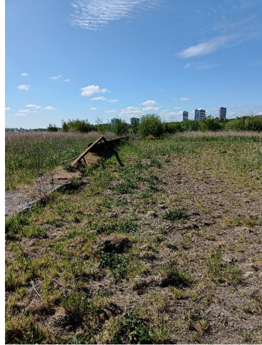
12. Indspulingsrør ovenpå den gamle dækmole, der går nord-syd gennem deponiet
