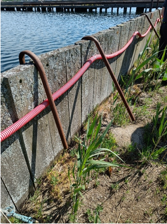
10. Støtte af spuns på deponiets nordside
