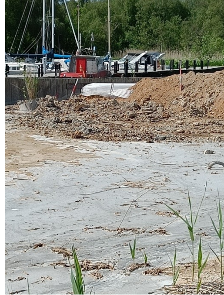
28. Delområde B, cementstabilisering og slutafdækning med sand
