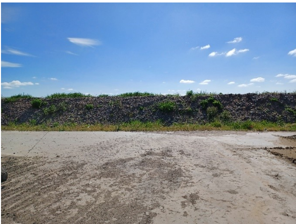
2. Vej ned til deponi, som ligger bag dige
