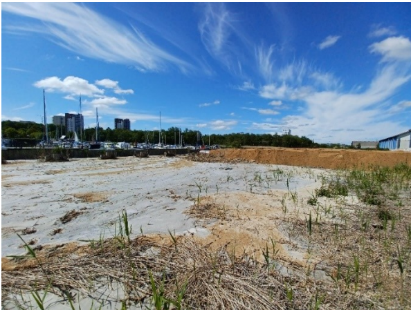
27. Delområde B, cementstabilisering og slutafdækning med sand
