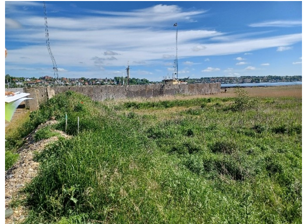
3. Mod nord fra top af dige, deponi t.h.
