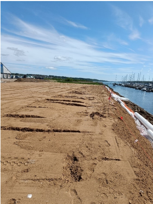
31. Orange signalnet og hvidt armeringsnet under slutafdækningsand
