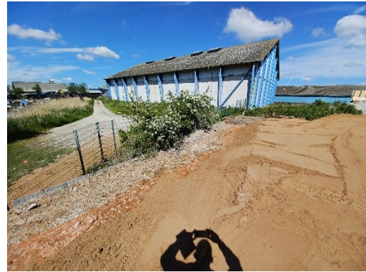
32. Orange signalnet under slutafdækning ved hegn langs vestlig ende af delområde B
