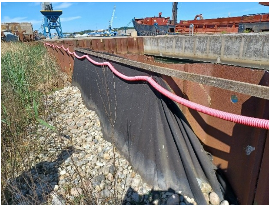
7. Metalspuns på nordside, eksempel på tætning med filterdug
