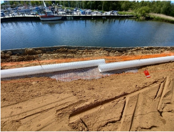
30. Orange signalnet og hvidt armeringsnet under slutafdækningsand
