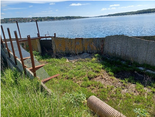
14. Skot og rørgennemføring i nordøstlig stenboks
