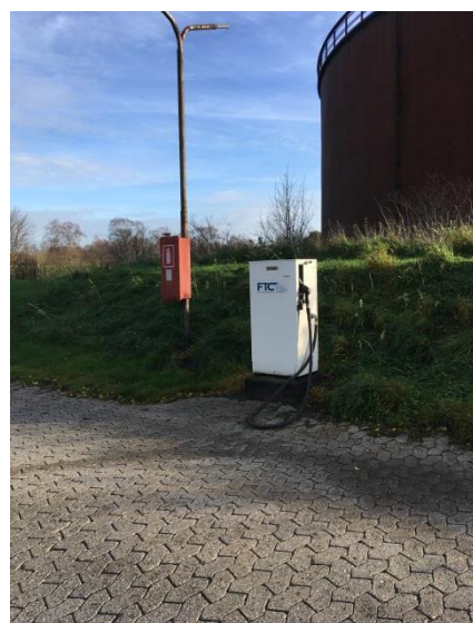
Foto af den nuværende tankstation, hvor olietanken ligger under. Pladsen har hældning ned mod en opsamlingsrende.
