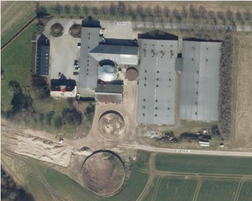
Figur 1. Oversigt over bygninger.
