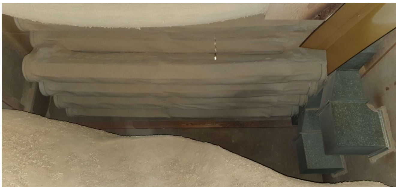
Posefilteranlægget i toppen af spånsiloen.
