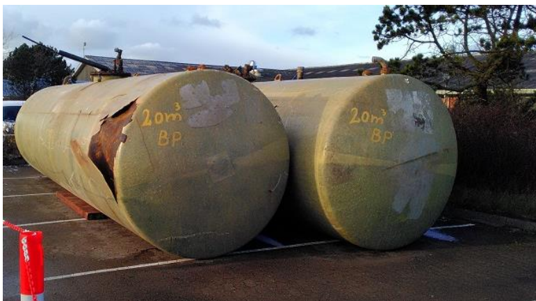
Billede 4. De to største tankegravet op på nedlagt dieseltankningsplads.
