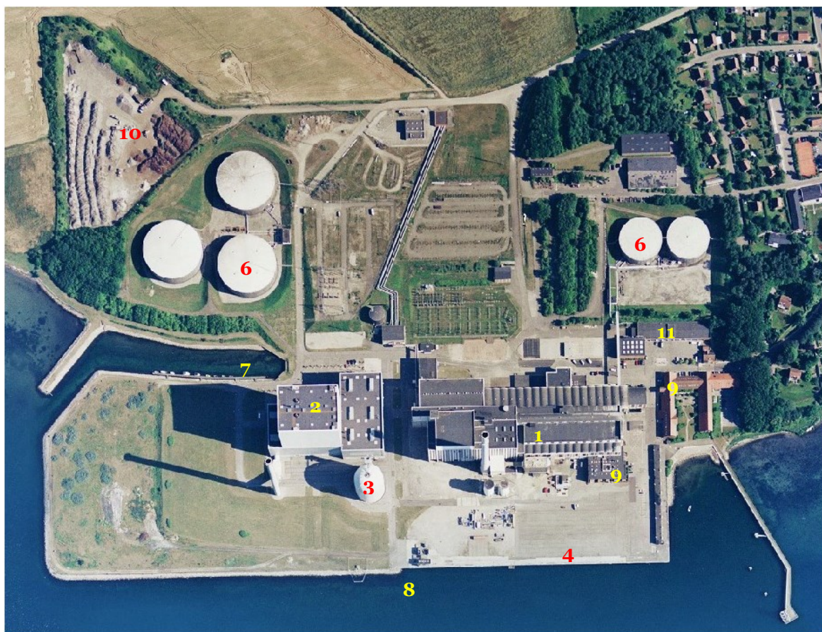
Figur 3: Luftfoto af Skærbækværket. Nummereringen angiver: 1: Blokbygning 1 og 2 med tilhørende hjælpeanlæg og skorsten. 2: Blokbygning 3 med tilhørende hjælpeanlæg og skorsten. 3: Fjernvarmeakkumulatortank. 4: Eksisterende indskibningskaj. 6: Lagertanke. Den vestligste anvendes til oplag af letolie til værkets drift. 7: Kølevandskanal – udløb. 8: Kølevandskanal – indløb. 9: Administrationsbygninger. 10: Mellemlager for restprodukter. 11: Bygninger udlejet til værksteder etc.
