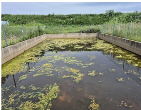
Billed 8. Opsamlingsbassin i den nordlige del af Miljøanlæg Skagen der opsamler overfladevand fra plads for brændbart affald.
