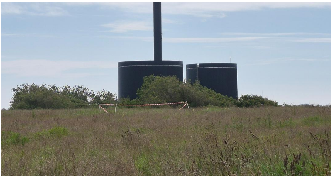
Billed 6. Markering der viser et gammelt asbestdepot på det nedlukkede deponi.
