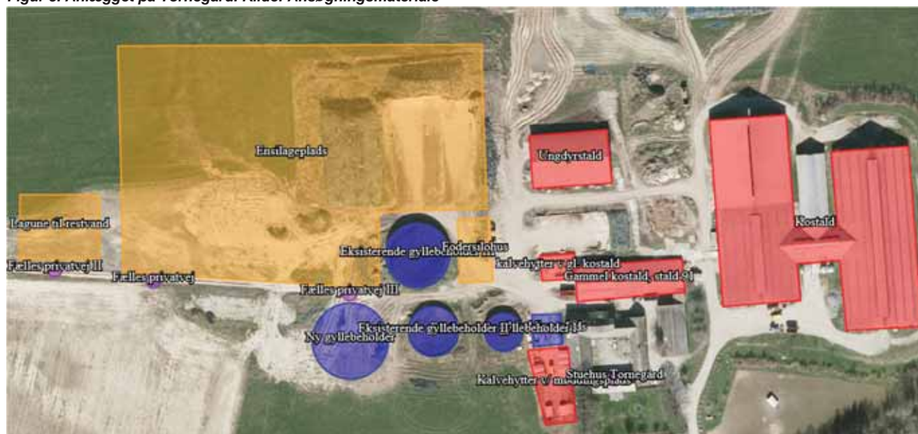
Figur 5. Anlægget på Tornegård. Kilde: Ansøgningsmateriale
