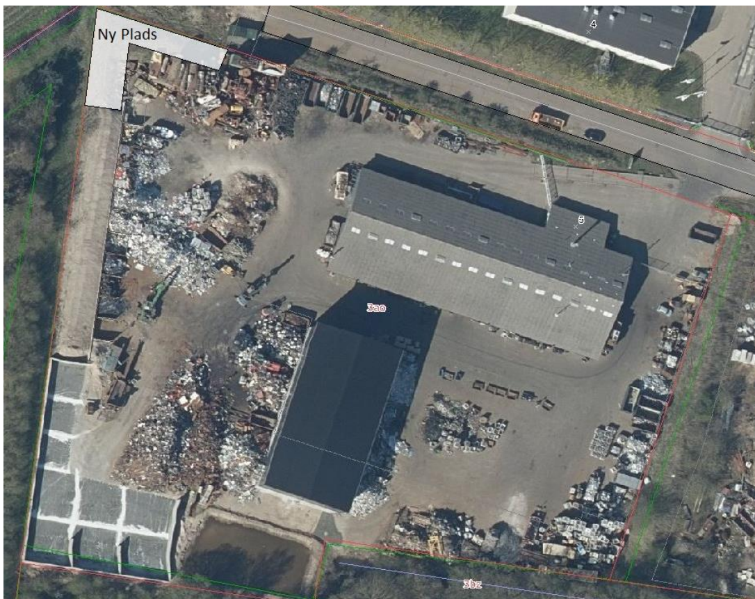
Figur 1. Frejasvej 5, set fra luften. Ortofoto 2019. Copyright Cowi.
