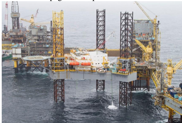
Figur 1 Eksempel på en rig placeret ved Dan F; Atlantic Labrador http://www.atlanticmarineservices.com/rigs/atlantic-labrador/
