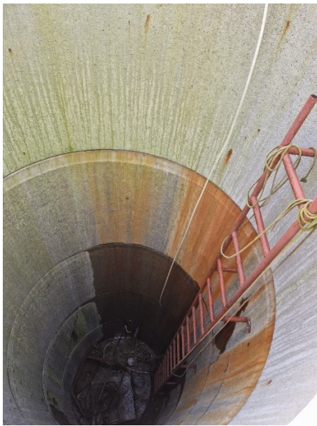
Foto 4. Åben brønd på depotet, ca. 8- 10 meter dyb ned til et dæksel.
