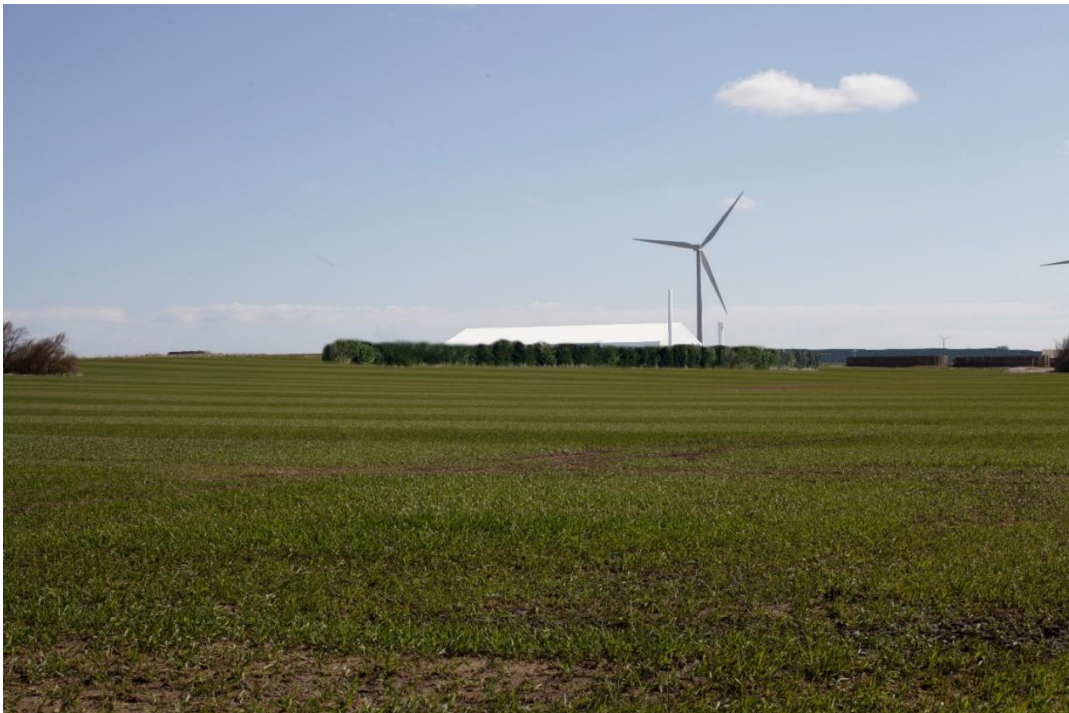
Visualisering af P2A-anlægget set fra indkørslen til Vandborgvej 83, ca. 400 m fra anlægget. Kilde: GeoPartner
