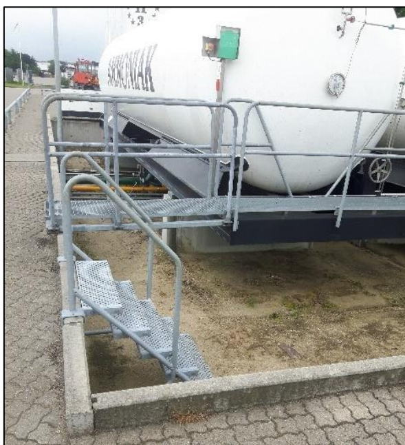
Figur 16 Eksempel på tankgrav under ammoniak-lagertank. Foto: WH-PlanAction
