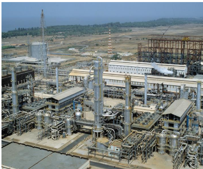
Figur 8 Et traditionelt indisk ammoniak anlæg der kan producere 3000 tons ammoniak i døgnet (Kilde: Haldor Topsøe A/S)
