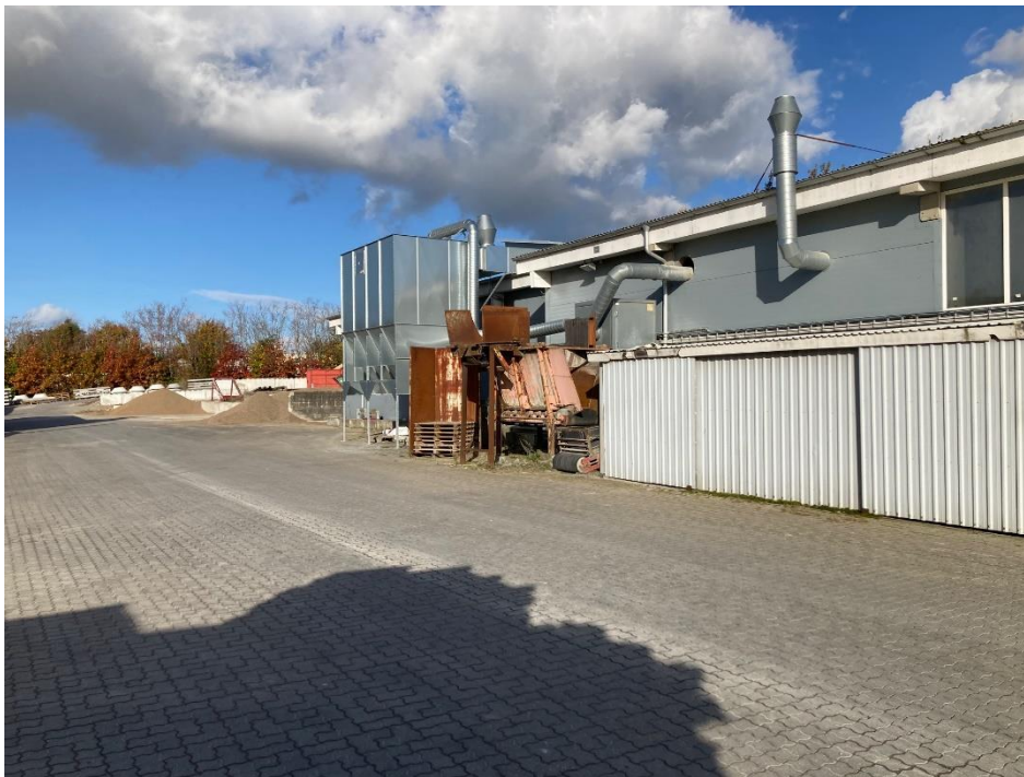
Ny ventilation til fabrikshallen for belægningssten.
