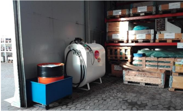
Ny tank i udendørs telthal.
