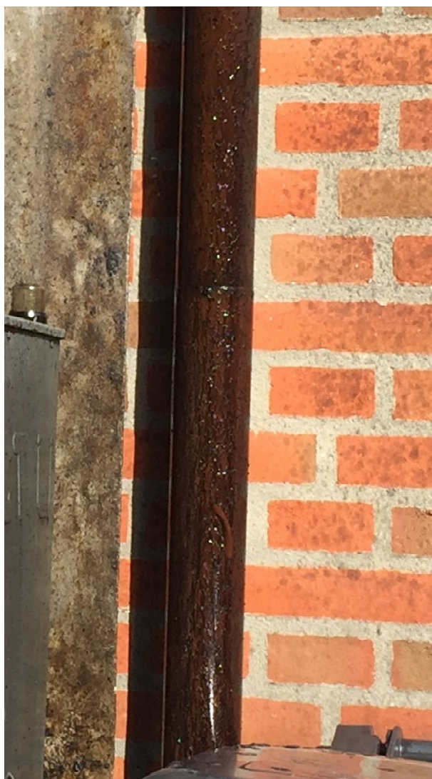
Nedløbsrør til regnvand med spildolie udenpå røret
