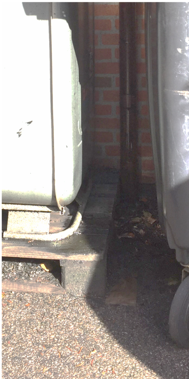
Spildolietank placeret ved siden af nedløbsrør til regnvand
