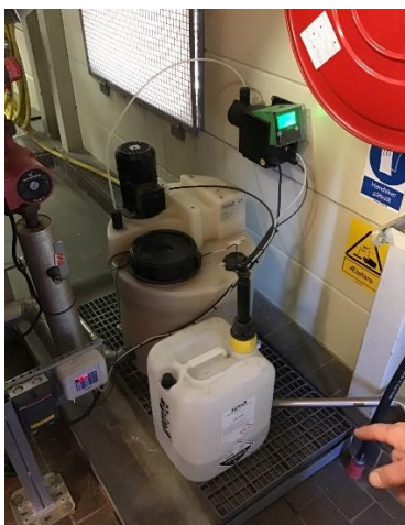
PH justering af kondensat.
