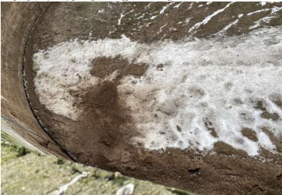
Mulige tegn på at der er hældt gylle ovenpå sneen i den lille gyllebeholder. Dette billede er taget lige ved siden af udløbsrøret.
