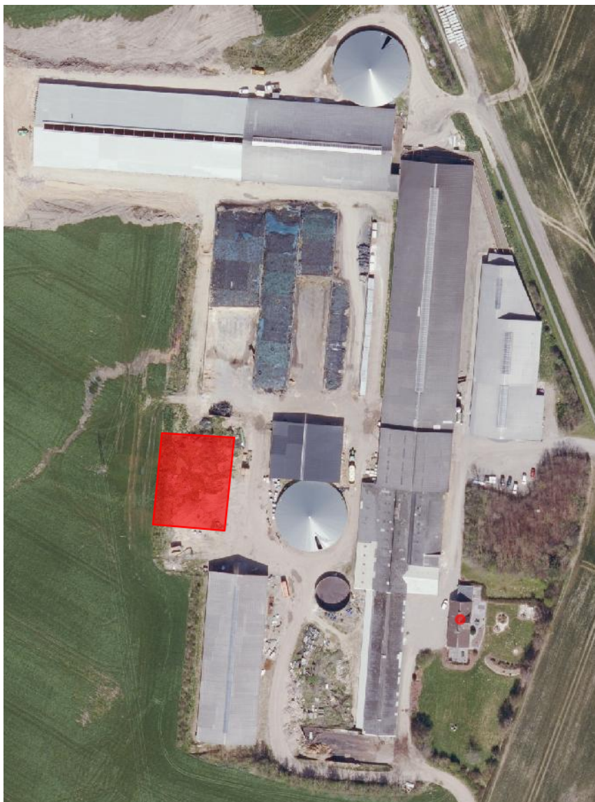
Figur 1. Luftfoto af husdyrbruget. Placeringen af det nye maskinhus er markeret med rød firkant
