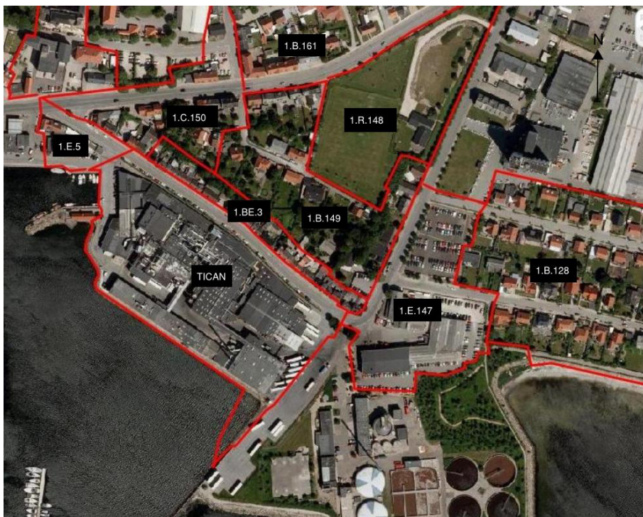
Figur 1 Virksomheden er placeret i Thisted by mellem havnen og boligerne mod nord
