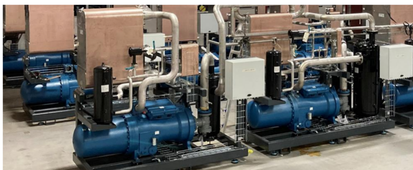
Figur 3 Den påtænkte indretning af varmepumperummet i fjernvarmebygningen. Hver fjernvarme-unit består af én indledende varmeveksler til fri varmeveksling (grøn markering) samt ét kabinet med to sæt varmepumper med kompressorer (grå kasser).
