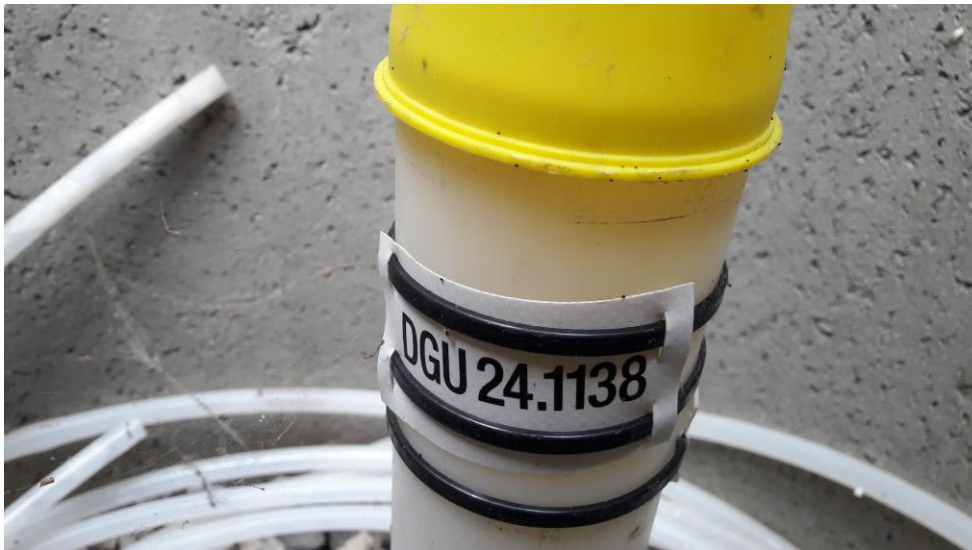
Den nyeste monitoringsboring med DGU 24.1138 afsluttet med plathætte
