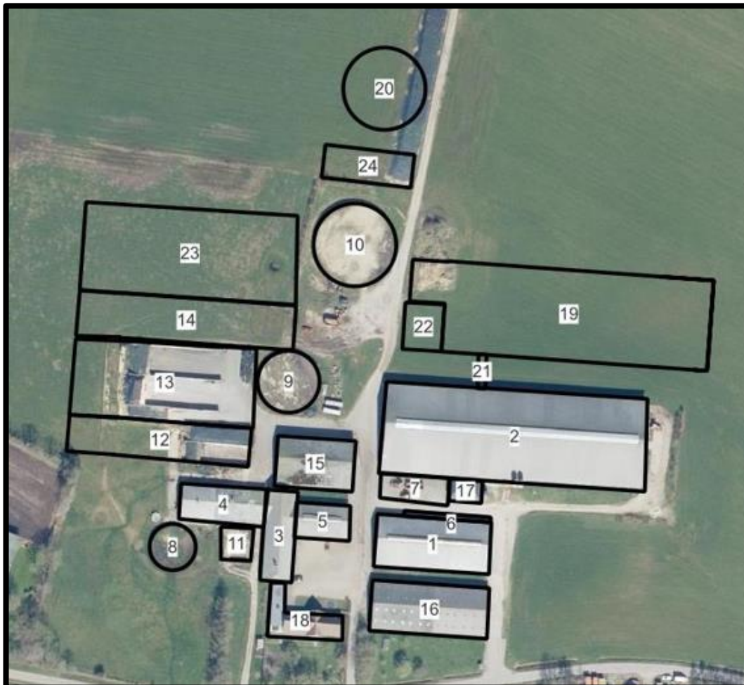
Figur 7 Oversigt over husdyrbrugets bygninger.
