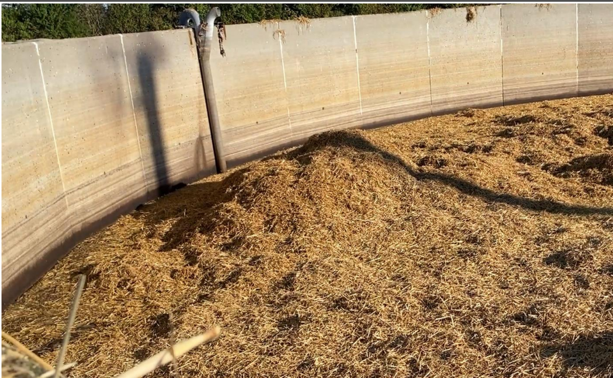
Gyllebeholder, dykket indløb
