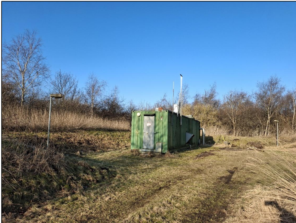
Foto 7: Container indeholdende gasindvindingsanlæg.
