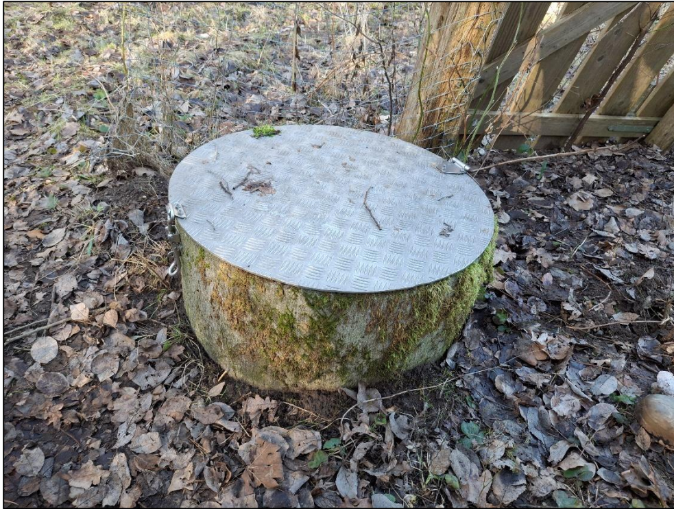
Foto 10: Grundvandsmoniteringsboring 61 (primært grundvandsmagasin)
