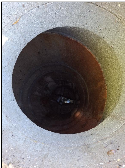
Foto 5 og 6: Brønd B10, hvorfra overfladevand fra adgangsvej ledes til kommunens regnvandsledning.
