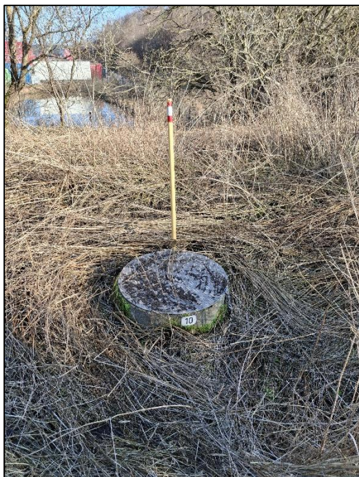
Foto 5 og 6: Brønd B10, hvorfra overfladevand fra adgangsvej ledes til kommunens regnvandsledning.
