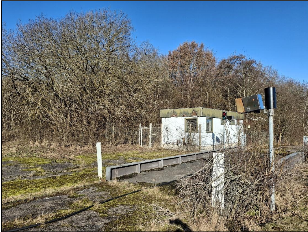
Foto 13: Mandskabsskur og vejebod ved indkørsel til deponiet.
