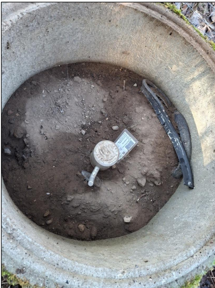
Foto 11: Grundvandsmoniteringsboring 61 (primært grundvandsmagasin)
