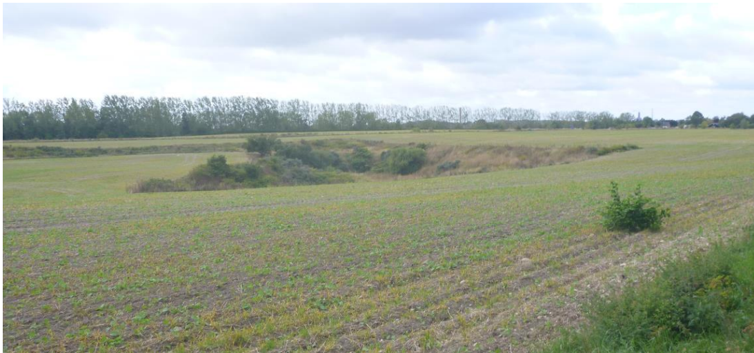
Figur 1 – Foto af det uopfyldte hul, taget fra den nordligste del af fyldpladsen ved skelgrænsen
