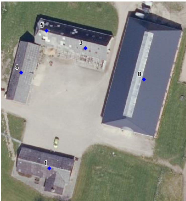
Figur 1. Eksisterende anlæg på ejendommen Smedebakken 6, 8740 Brædstrup. Bygning 3 og 5 ønskes nedrevet og erstattet med ny stald
