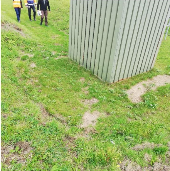
BILAG 2: Spildstedet ved mobil transformator ses fuldt reetableret.
