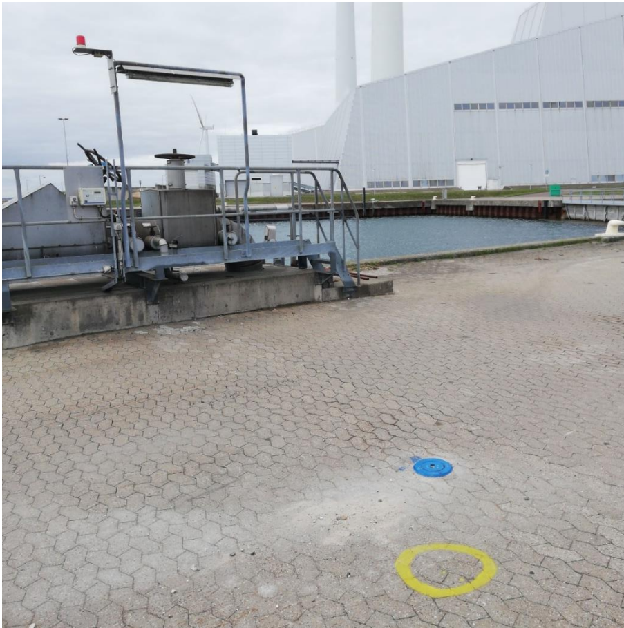
BILAG 3: Ved revurderingen udarbejdes en basistilstandsrapport, og i denne forbindelse udføres en række borer. Placeringen af en del af disse borer (blåt aflukningsdæksel) blev besigtiget ved tilsynet. Her på oliekaej ved bunkringanlæg.
