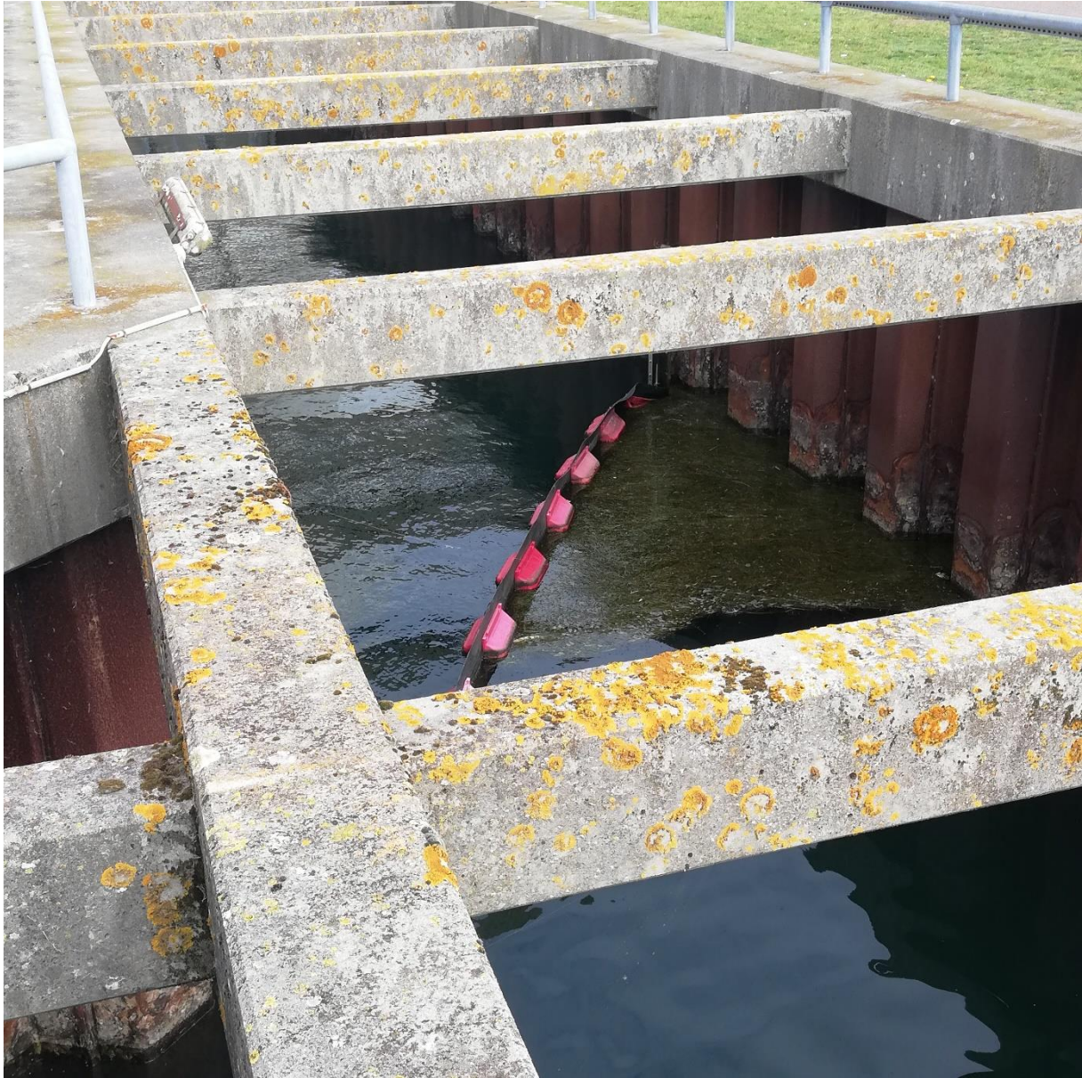
BILAG 7: Kølevandskanal for afgang af kølevand fra Blok 2. Flydespærre er fast anlagt til skimning af overfladen.
