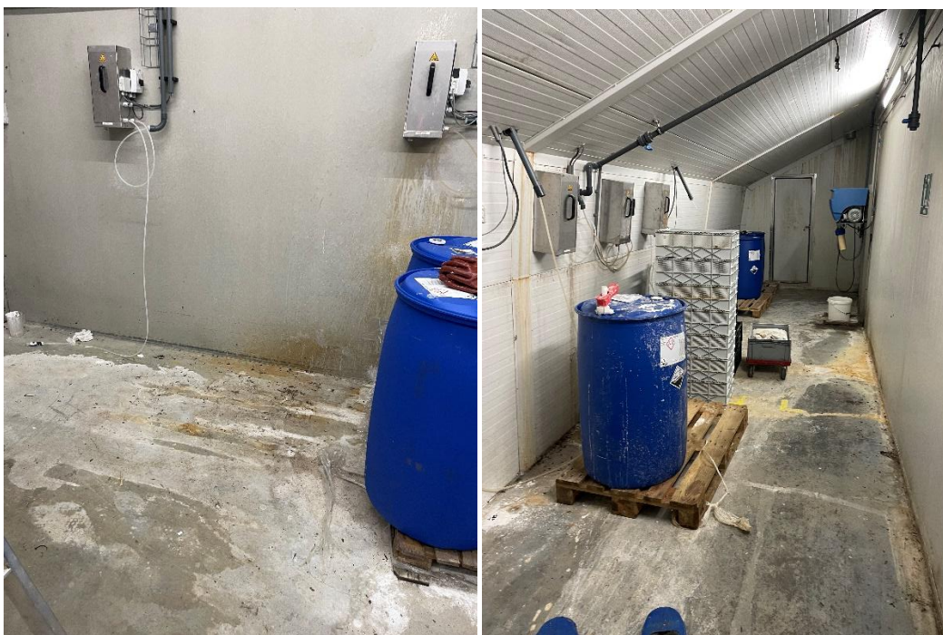
Tønder med syre og lud opbevares nu i separate rum på fast gulv uden afløb
