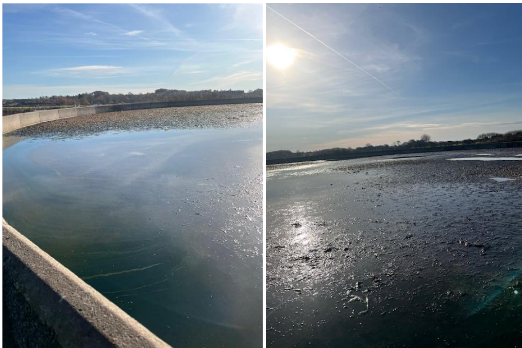
Gylletank med mangelfuldt flydelag. November 2025
