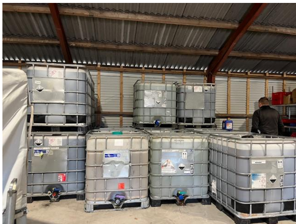
Pallettanke på værkstedet med fast gulv med afløb til regnvandsopsamling. November 2025.
