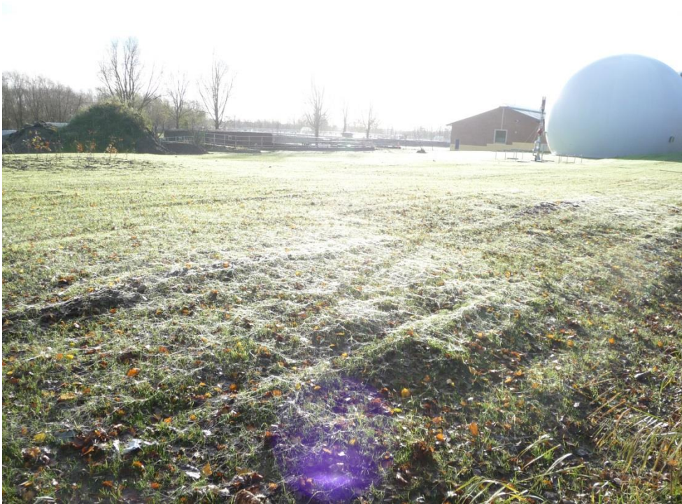
Figur 4 Billeder af arealet, hvor der i forbindelse med etablering af den hvide kuppel i baggrunden blev gravet ind i kanten af deponiet. Arealet er igen afdækket og det vurderes, at kravet om slutafdækning er opfyldt.
