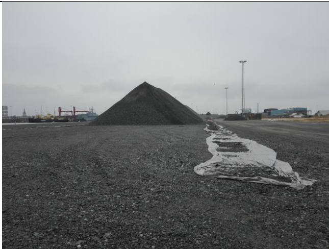
Oplag af skærver, grove såvel som findelte). Der er lagt en fibertex ud over perkolatrender, så de ikke fyldes med fintknuste skærver.
