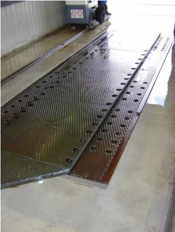
Afløbsrende i vaskehallen
