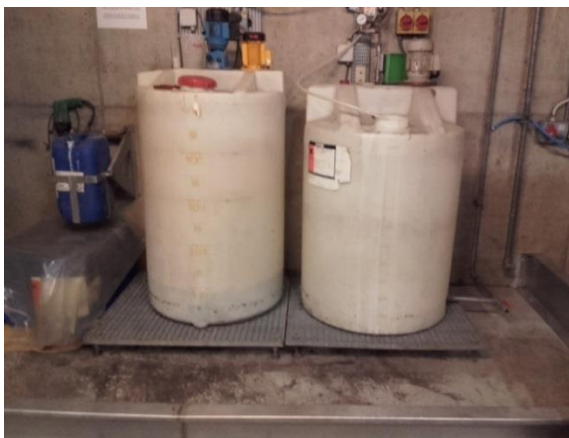
Billede 1 - metalkant opsat til at bremse eventuelt spild fra at nå afløbet (ude af billedet)
