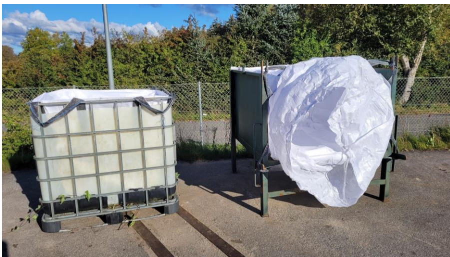
Modtage-ø for asbestaffald – hele plader til venstre
