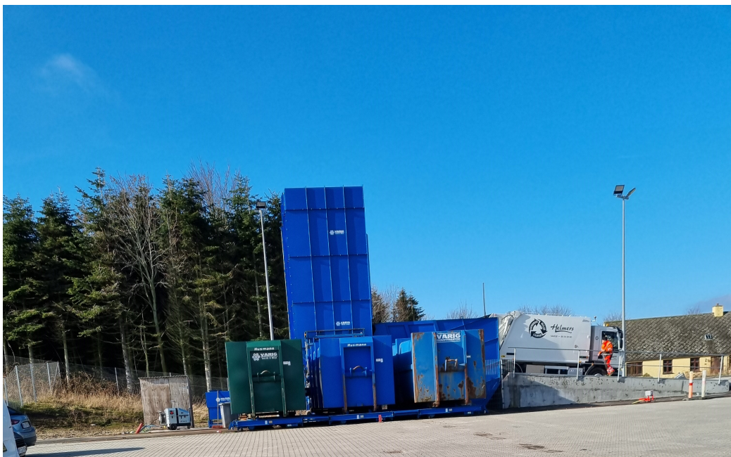
3 komprimatorcontainere med henholdsvis madaffald, restaffald og papaffald.
