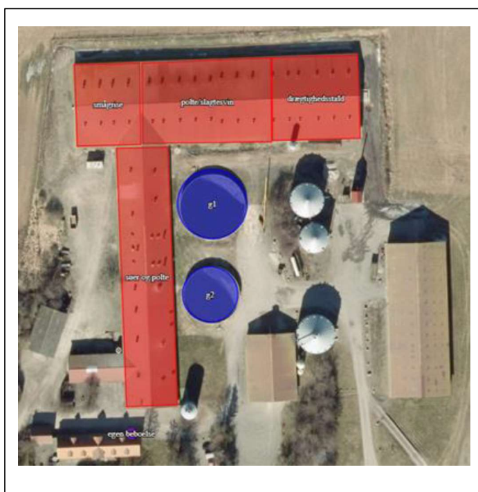
Figur 1. Staldanlæg på Alleshavevej 64
