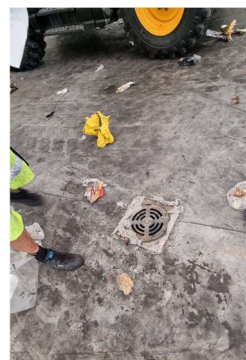
I telthal, tæt belægning og etablering af afløb
