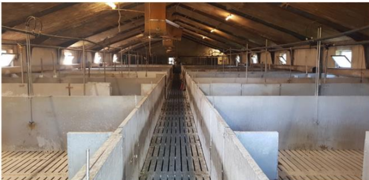
Vådfodring og mekanisk ventilation med vægindsug.
