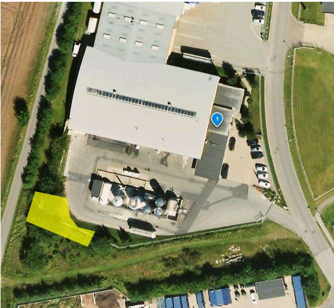
Foto af anlægsarealet – Parti 1.
