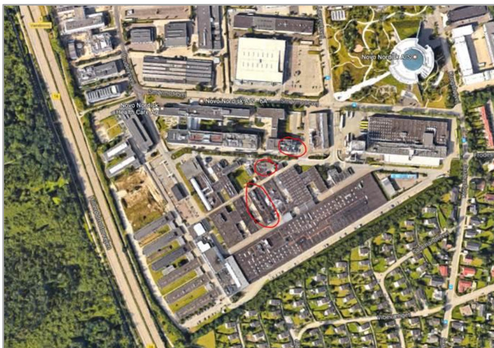
Figur 1. Virksomhedens bygninger. Tre røde ringe angiver de bygninger, som tilsynet omfattede.
