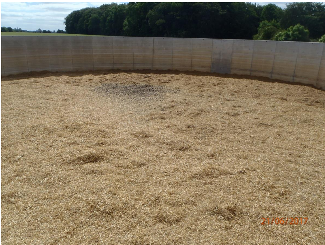
Billede viser tilstrækkeligt flydelag på gyllebeholderen på 3500m 3
