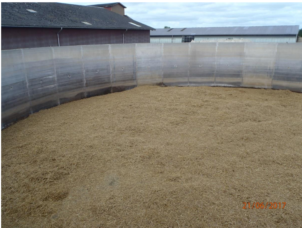
Billede viser tilstrækkeligt flydelag på gyllebeholderen på 1200m 3
