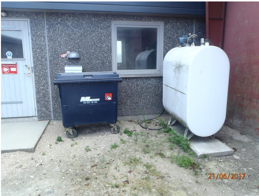
Billede af olietank på 1200 liter ( Til Dieselolie )
