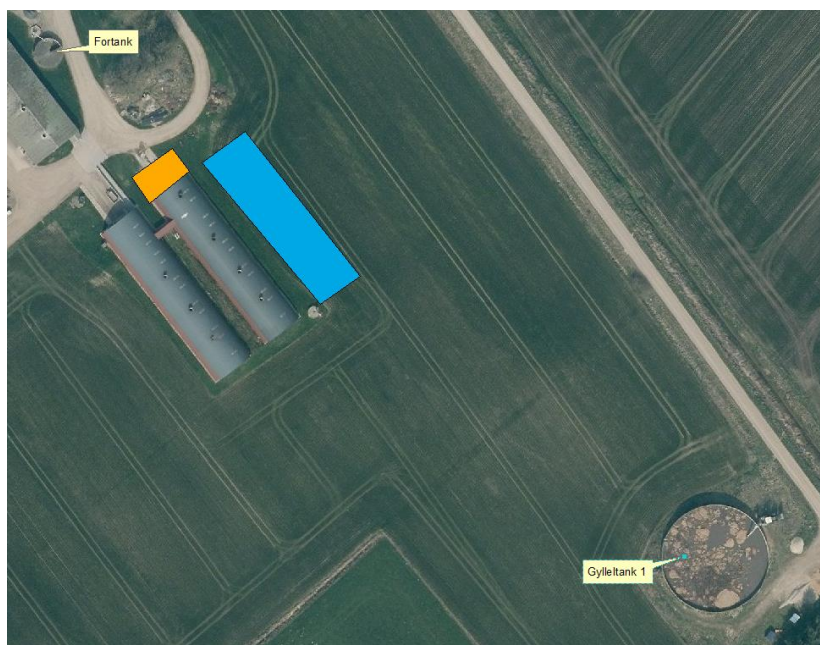
Figur 4. Gylletanke på Kærvej 51
