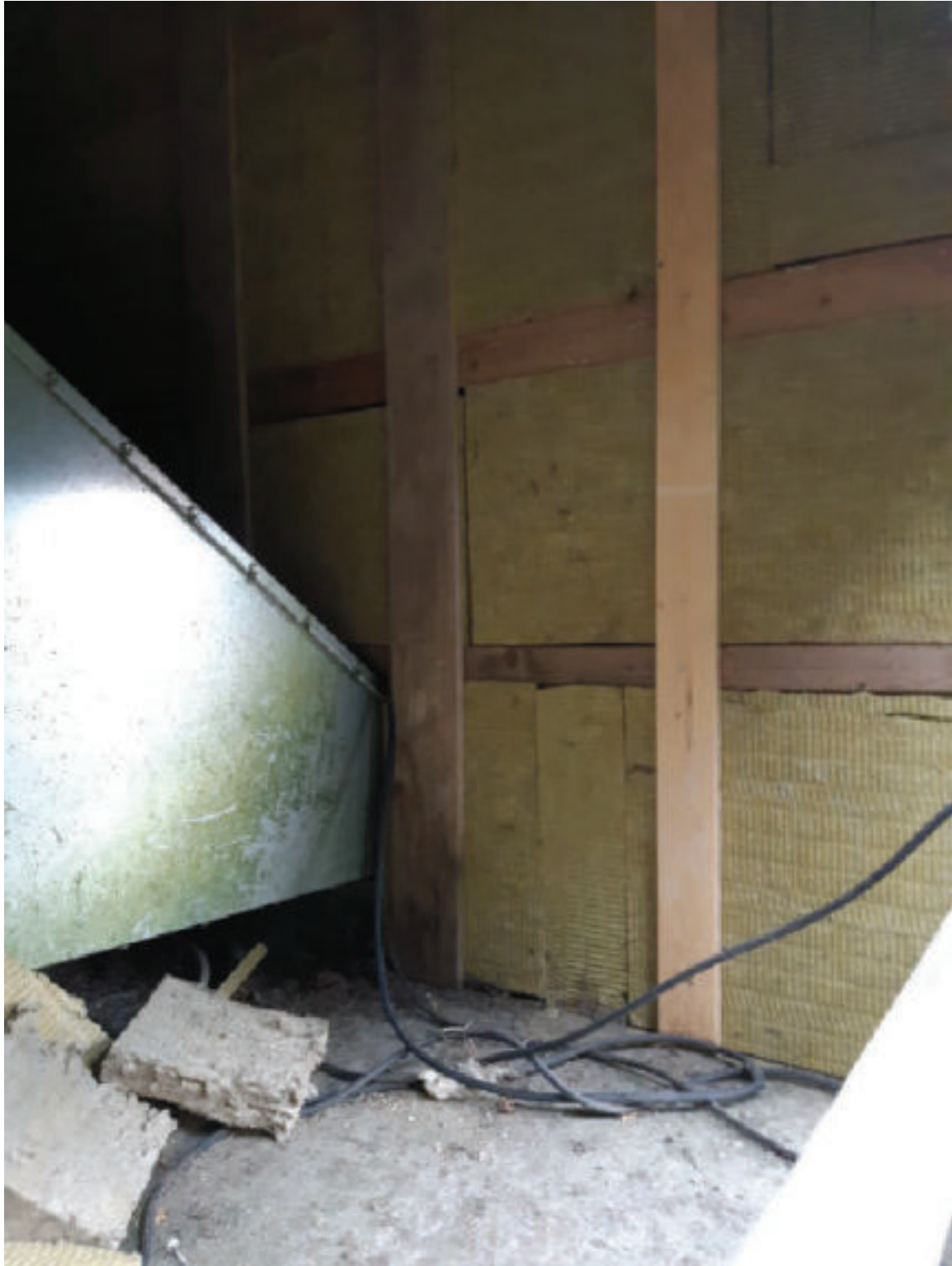
Foto, indvendig beklædning i bulderhus.
