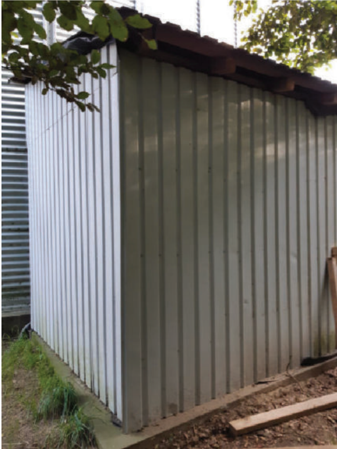
Foto syd for silo, fotoretning NNØ
