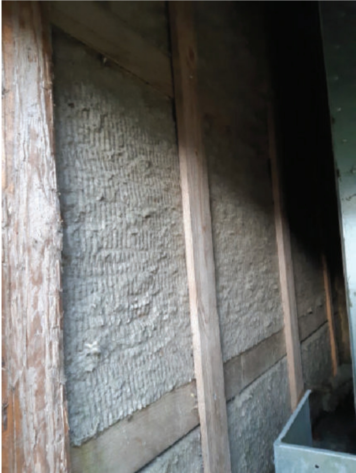
Foto, indvendig beklædning i bulderhus.
