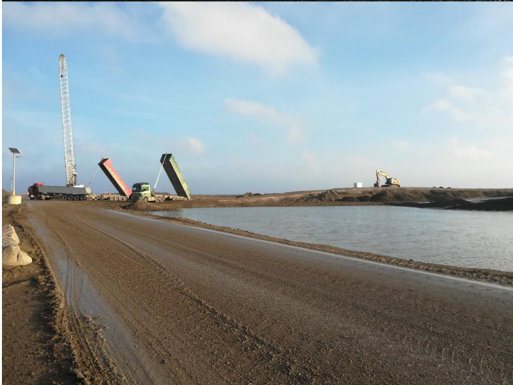
De tre billeder herunder er taget fra cellefangsdæmningens nordøstlige hjørne og viser udledningspunkt for overskudsvand fra deponiet.
