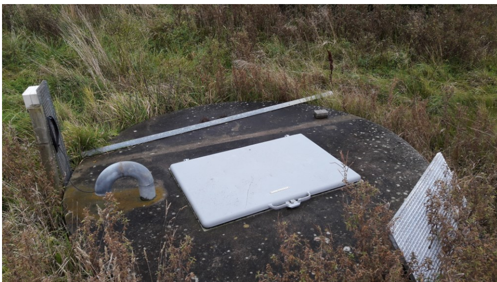
Fig. 9. Pumpebrønd til perkolat (én ud af tre brønde på samme lokation) umiddelbart nedstrøms etape 5a
