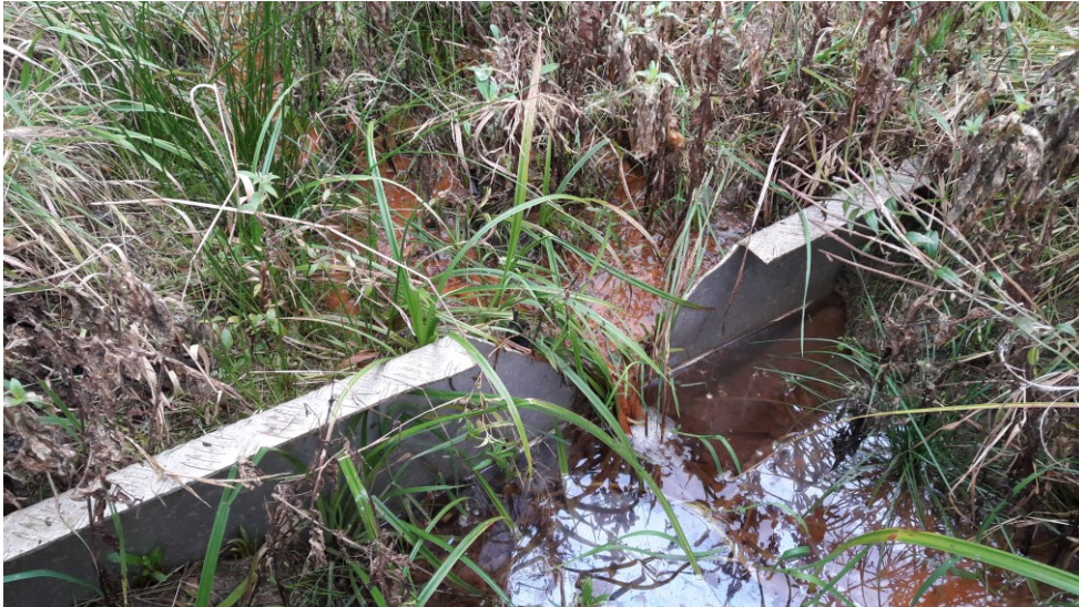
Fig. 16. Opstemning med overfald til prøvetagning af overfladevand for foden af etape 5b.
