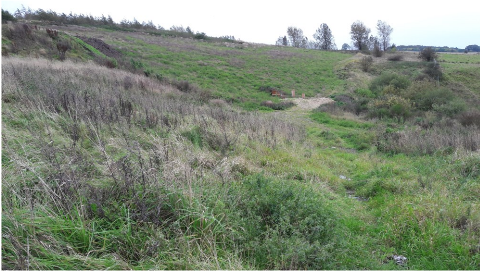
Fig. 15. Etape 5a er under slutafdækning med ren jord.
