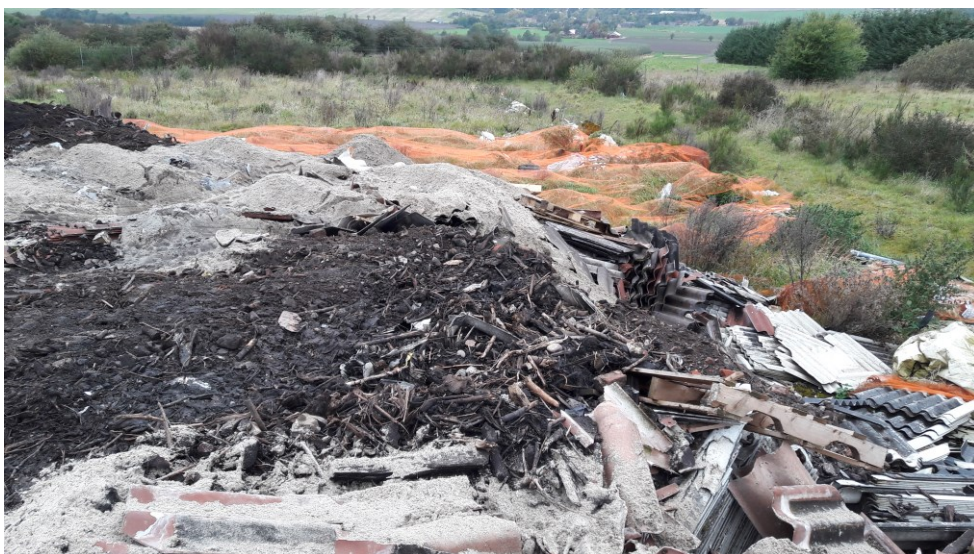
Fig. 13. Asbest-deponeringscelle med markeringsnet i bunden
