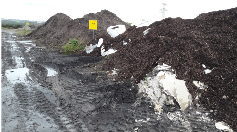
Fig. 12. Celler på etape 5b til deponering af hhv. PCB-holdigt affald (forrest) og asbestaffald (bagerst).
