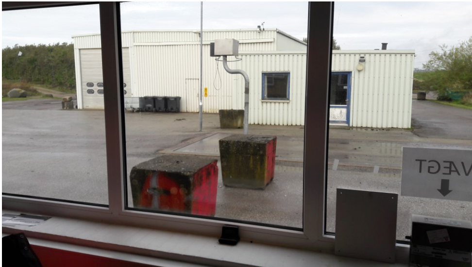
Fig. 2. Indvejekontrol på Feltengaard Deponi. Der er videoovervågning ved brovægten og betonklodser forhindrer lastbiler i at køre uden om brovægten.
