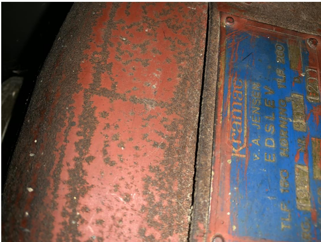
Mærkeplade 1200 l tank, årgang 1967. Reservetank til fyringsolie. Tanken skal sløjfes.
