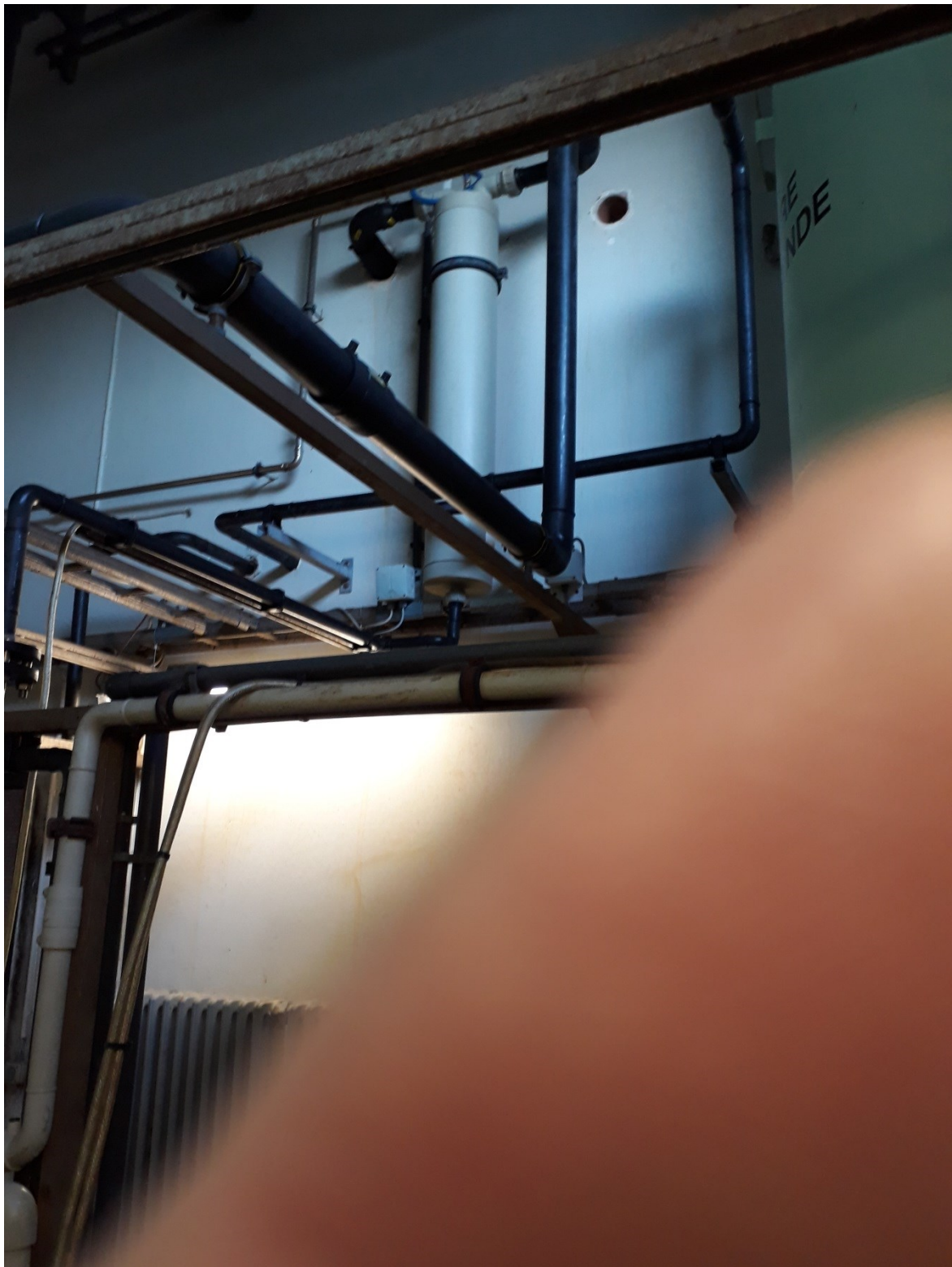
Bilag 1: Syredampvasker (lyst rør i midten af foto)
