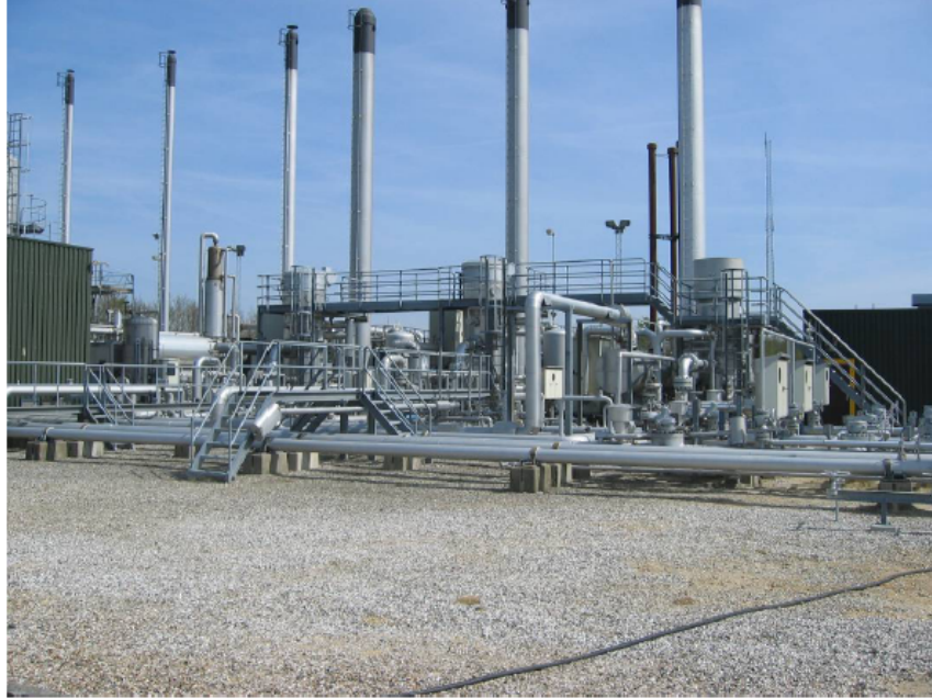
Figur 8.4 Gasforvarmere
