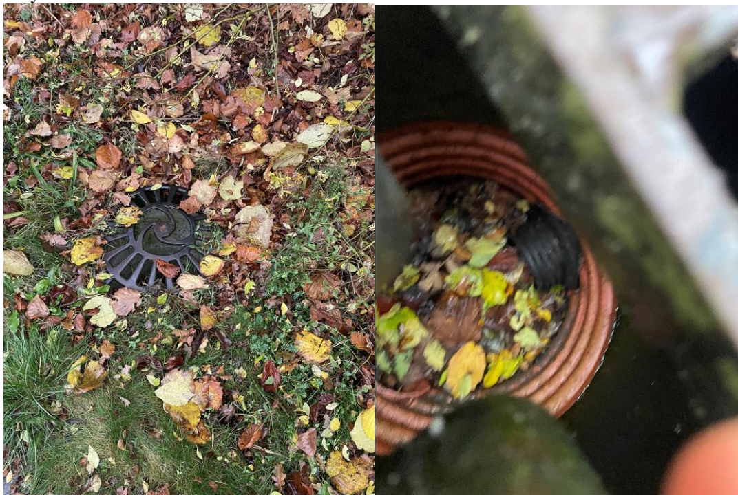
Figur 6: Afvandingsbrønde konstateret på forrige tilsyn
