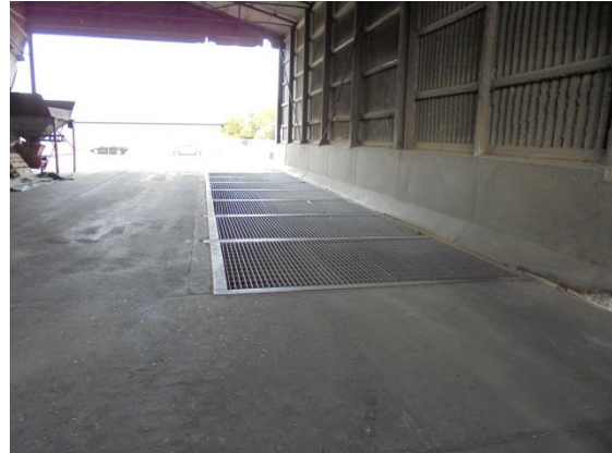
Påslag-Nord i siloanlægget
